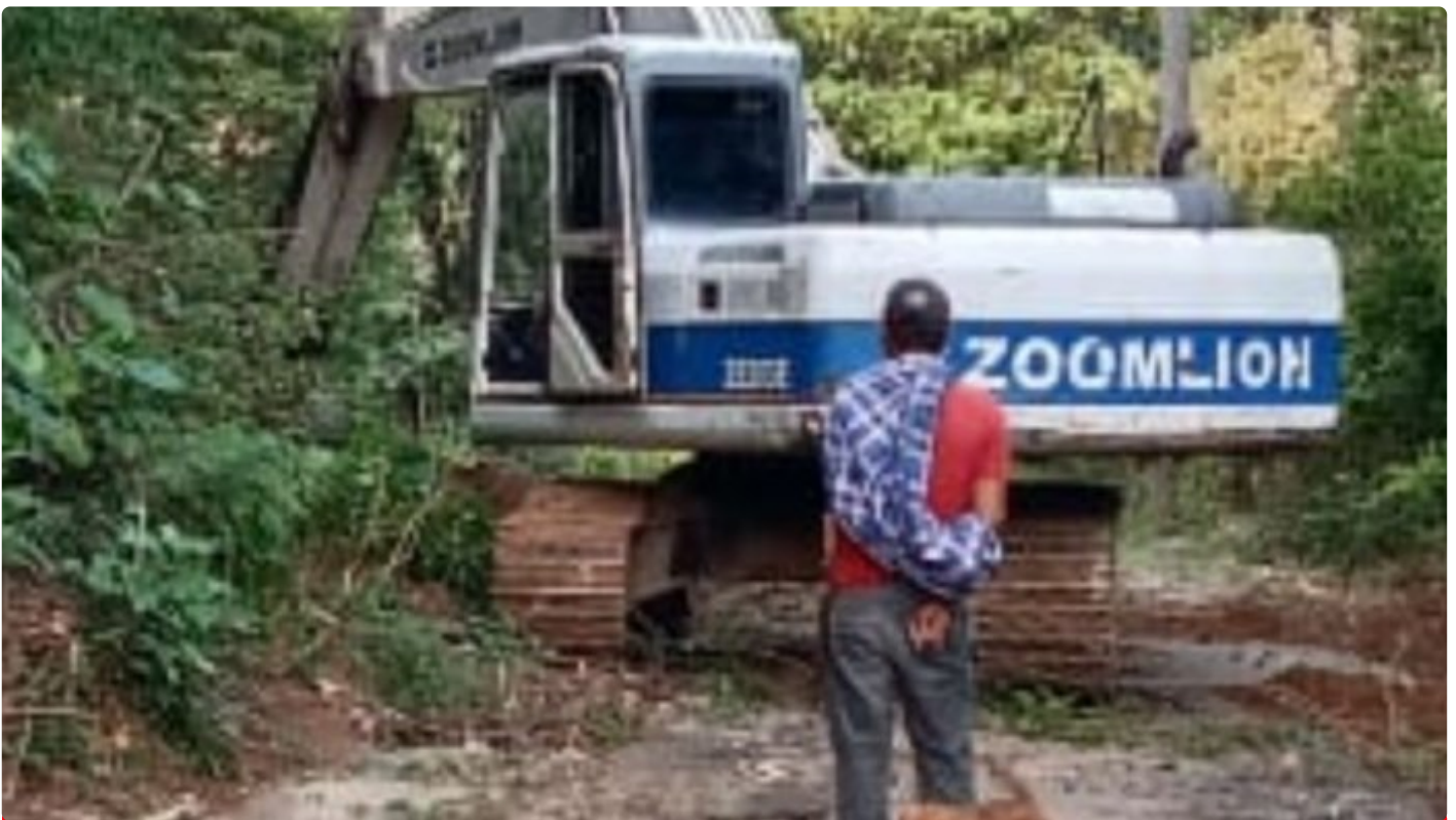
Owner Pujananting Group Muh. Arif Kerahkan Alat Beratnya Perbaiki Jalan Punranga - Gattareng
